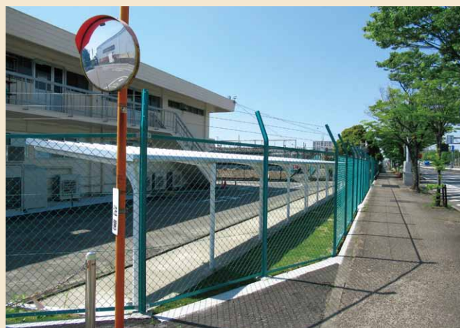
改修後のネットフェンス
