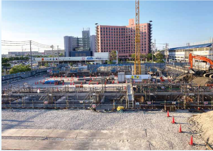
2023年5月初旬時点での工事の様子
