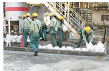
漏えい物質流出防止のための土嚢積み（名古屋工場）
