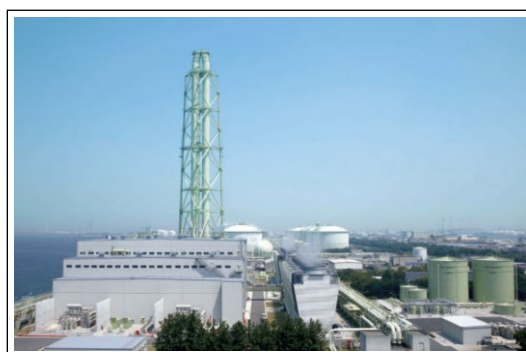
<Daigasグループ 泉北天然ガス発電所の写真>
