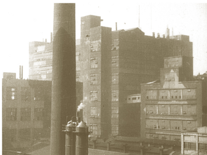
1934 (昭和9) 年竣工のL工場 (中央)
