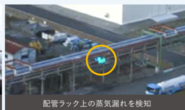
配管ラック上の蒸気漏れを検知
